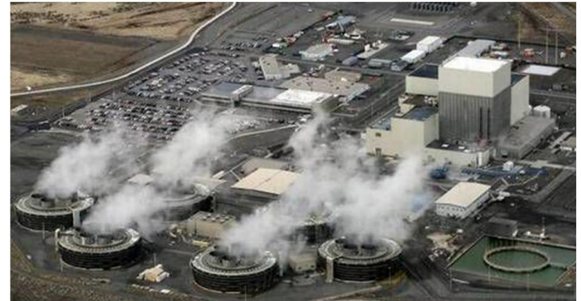
コロンビア発電所 (エネルギーノースウエスト)
